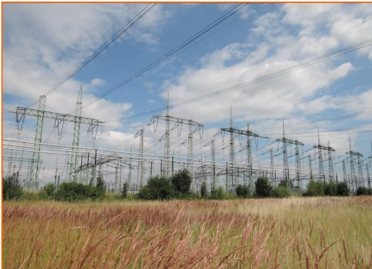
Obrázek č. 18: Transformační stanice v Nošovicích 62
