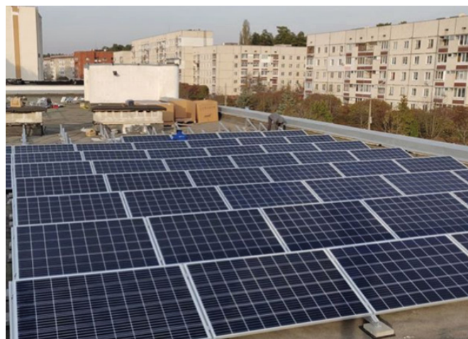
Fotovoltaické panely energetického družstva SolarTown ve Slavutyči. Zdroj: www.ua.undp.org
